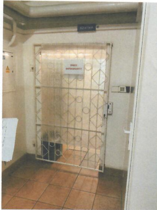
Fotografia 6. Pomieszczenie szatni damskiej w poziomie piwnic zamykane kratą
