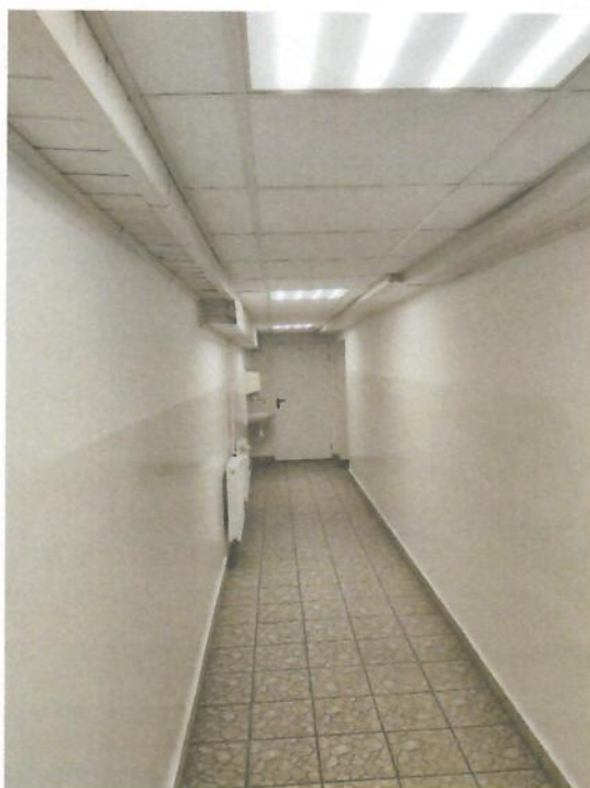
Fotografia 7. Korytarz w poziomie piwnic o wysokości 2,16 m
