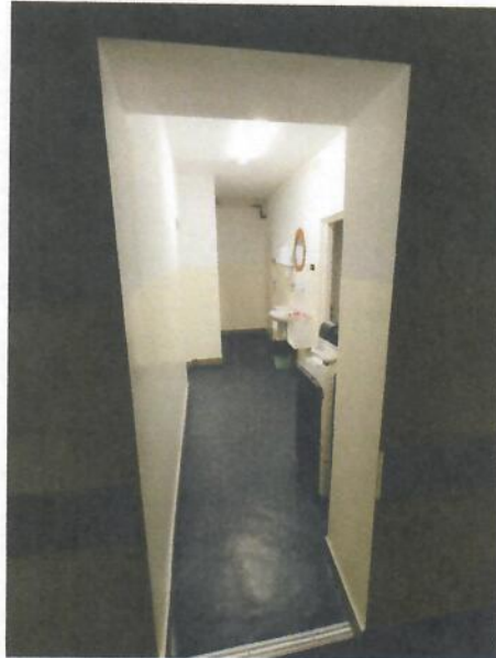
Fotografia 5. Dwa lokalne przewężenia do 0,79 i 1,1 m w korytarzu w poziomie piwnic
